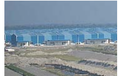
クラン港自由貿易区に建設中の賃貸工場スペース（同区運営会社提供）
